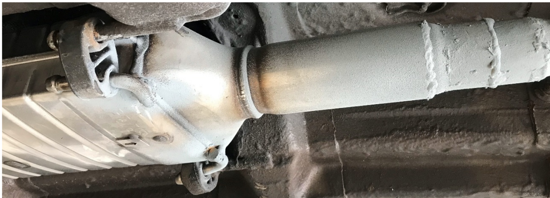
Udgang fra DPF reduceres og svejse med rør. Rustfri rundjern bøjes og svejse på DPF til gummiophæng.
